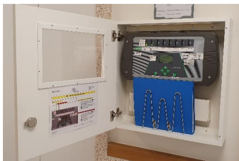
7.1. Bild 1: Siemens / MSA GasGard XL- Zentrale
